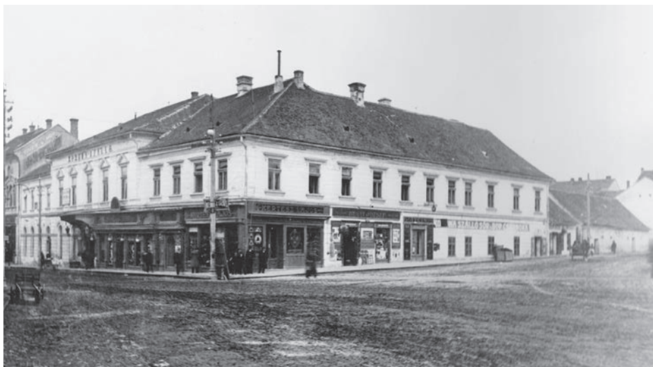
A Korona Szálló a Korona – 1946-tól Ady Endre – utca első „névadója” a 20. század elején
